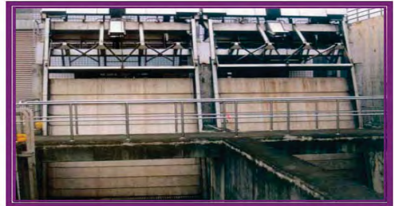
圖4-4 固定鋼索式撈污機示意圖
