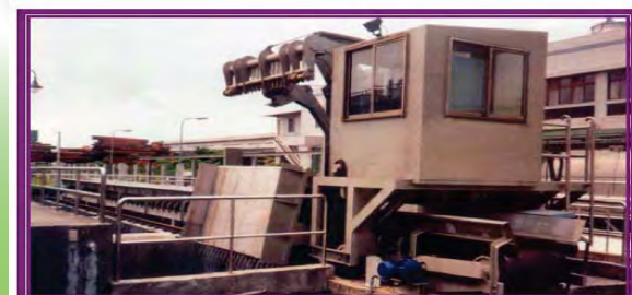
圖4-3行走式撈污機示意圖
