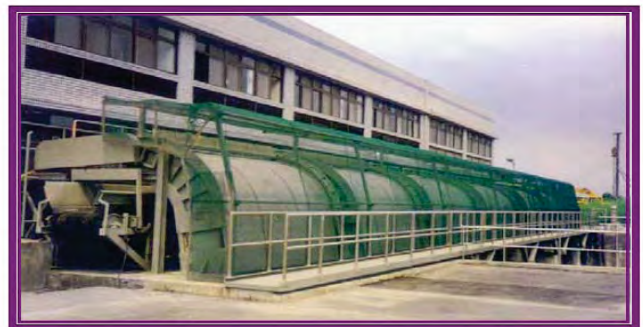
圖2-4刮迴轉式撈污機示意圖
